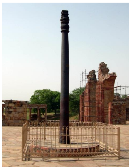
Obr. 1.2 Nerezavějící železný sloup v Dillí [2].
