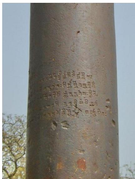
Obr. 1.2 Nerezavějící železný sloup v Dillí [2].
