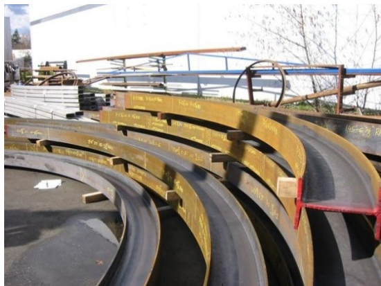
Obr. 9.15. Širokopřírubové nosníky připravené na stavbu mostní konstrukce
