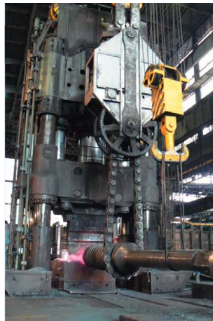
Obr. 1.53. Vítkovice – lis 120 MN, před rekonstrukcí v roce 2008
